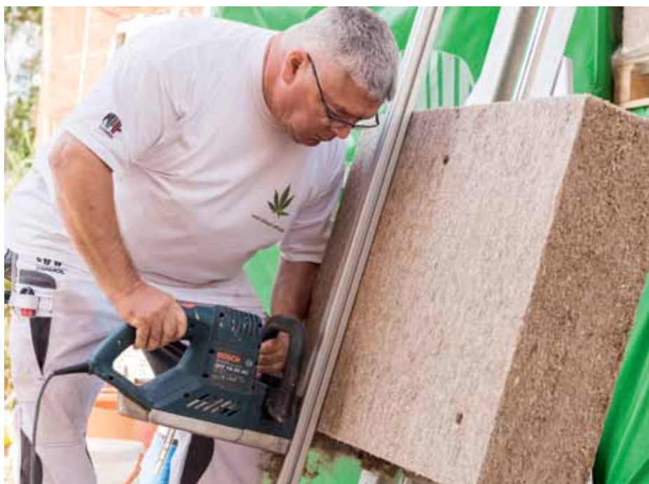
Exakter Zuschnitt: Hanfplatten des Fassadendämmsystems Capatect Natur+ lassen sich vor Ort maßgenau zuschneiden. Anbieter Caparol empfiehlt Verarbeitern dafür das passende Werkzeug
