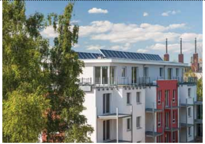
Das zusätzliche Geschoss wurde mit Holzfaser-WDVS gedämmt
