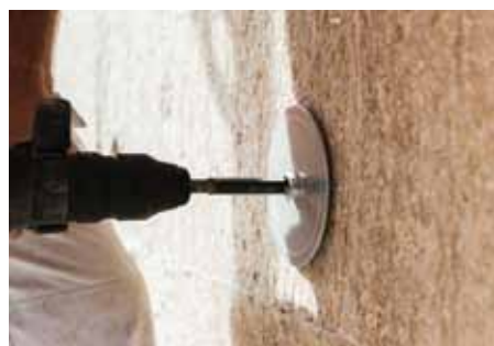
... und anschließend mit jeweils acht Tellerdübeln sicher im Mauerwerk verankert
