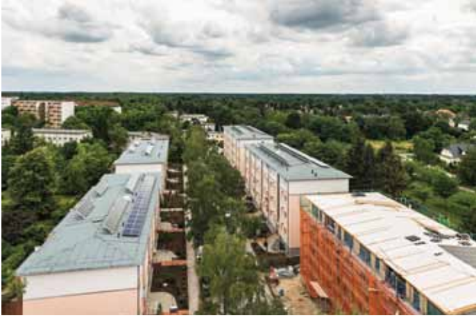
Direkter Vergleich: Fünf Bestandsgebäude wurden zu Vergleichszwecken mit unterschiedlichen Dämmmaterialien saniert
